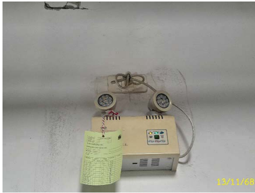
เครื่องส่องสว่างฉุกเฉิน
